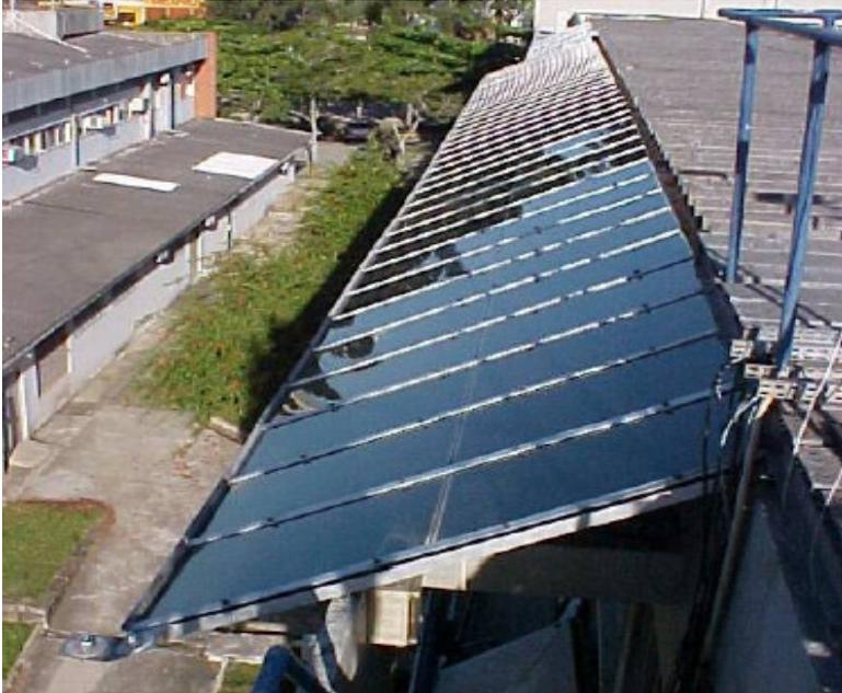
Figura 2.2. Gerador fotovoltaico de 2 kWp conectado à rede e integrado a uma edificação, instalado em Florianópolis-SC, em operação desde 1997.
