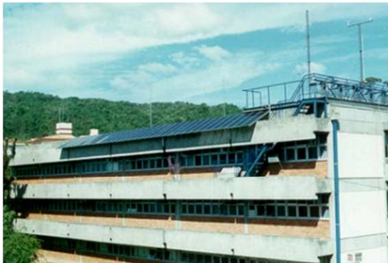
**Figura 24. Primeiro sistema FV conectado à rede instalado no Brasil (1997), com módulos de filme fino de Silício amorfo hidrogenado (a-Si:H) integrados a uma edificação.**
