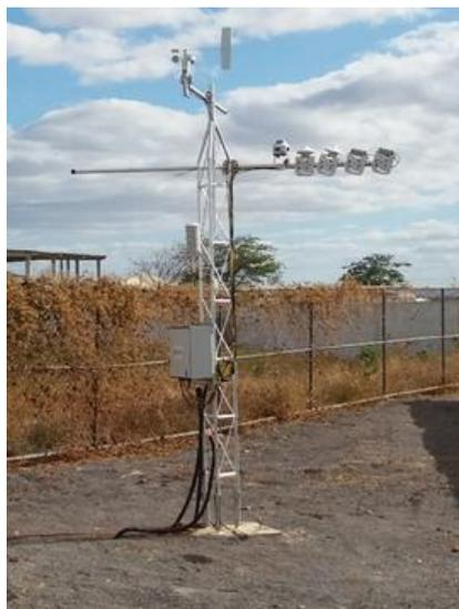
Figura 1 - Estação solarimétrica instalada junto à usina em Irecê-BA.
